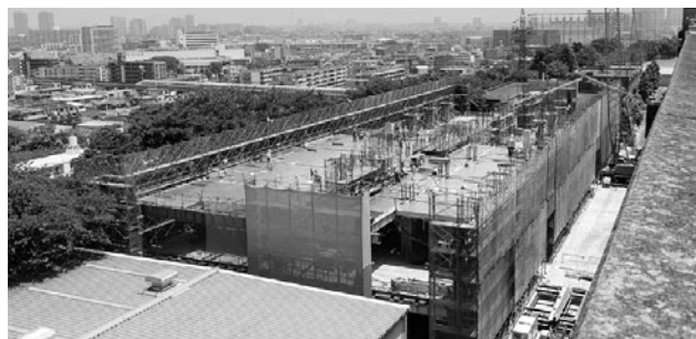
建設中の新34棟（仮称）
