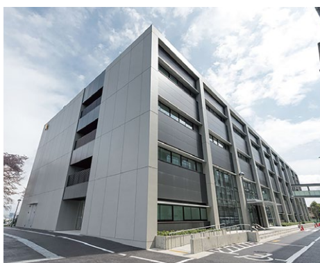
34棟 / 教育研究棟
