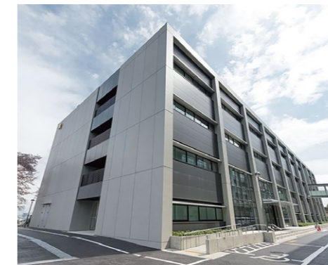
34棟 / 教育研究棟
